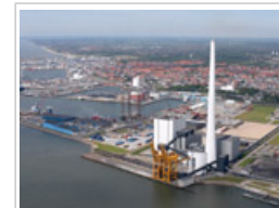
La central eléctrica de Esbjerg, en Dinamarca, un lugar para la captura de CO 2 Fuente: DONG Energy
