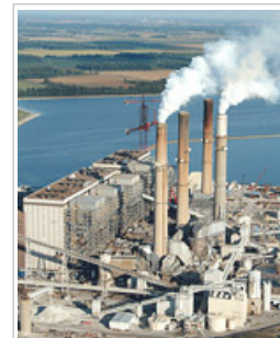
La centrale au charbon de Gibson, un bon exemple d'importante source stationnaire d'émissions de CO 2 Source: John Blair, valleywatch.net [voir http://valleywatch.net/ ]
