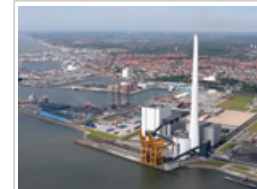
La centrale électrique d'Esbjerg au Danemark, un site de piégeage du CO 2 Source: DONG Energy
