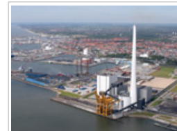
La centrale électrique d'Esbjerg, une installation de captage de CO 2 située au Danemark. Source: DONG Energy
